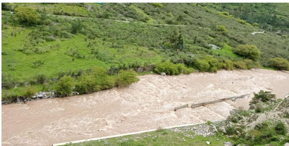
FOTOGRAFIA N°02: TRAMO CRÍTICO EN EL RÍO CHIRIS, ENCONTRÁNDOSE SOCAVADO LA DEFENSA Y EXPUESTO A PELIGRO EL CANAL PRINCIPAL DE TICRAO.
